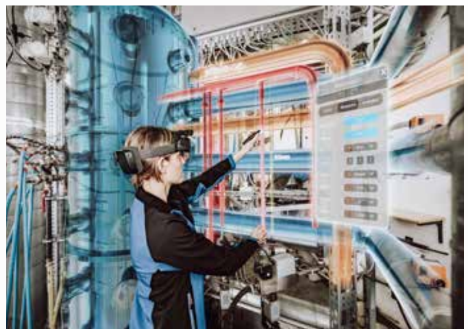
Abbildung 27: AR-Brille unterstützt bei Wartungsarbeiten
